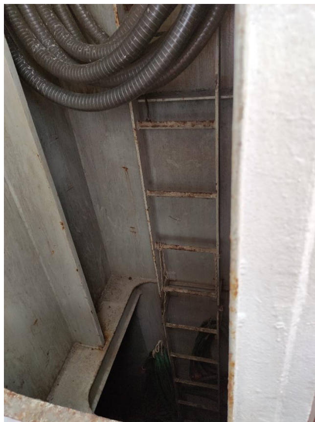
Figura 10. Escala de bajada en el acceso popa babor
